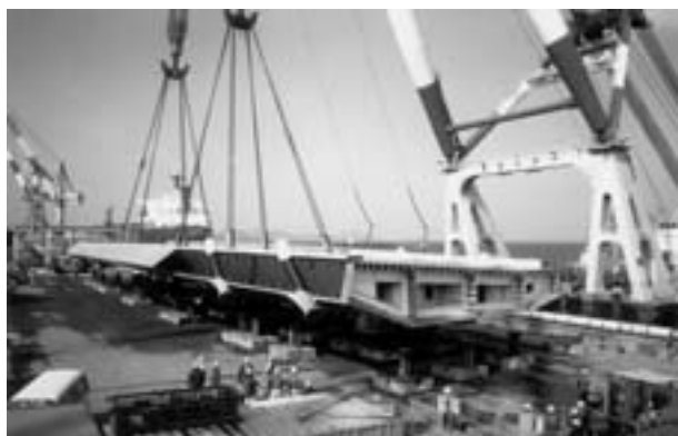
写真2 主桁大ブロック浜出し状況
