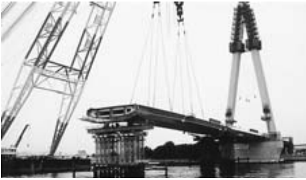
写真3 主桁大ブロック架設状況
