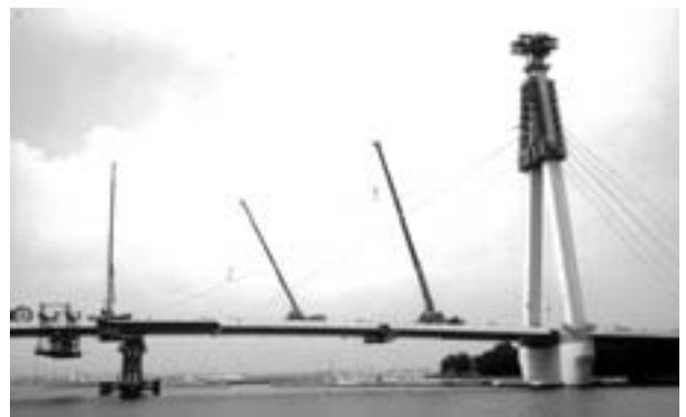
写真4 ケーブル架設状況
