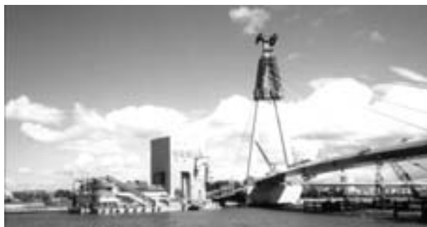
写真5 重量コンクリート打設状況
