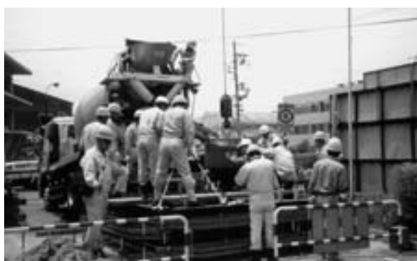
写真1 重量コンクリート施工性確認試験
